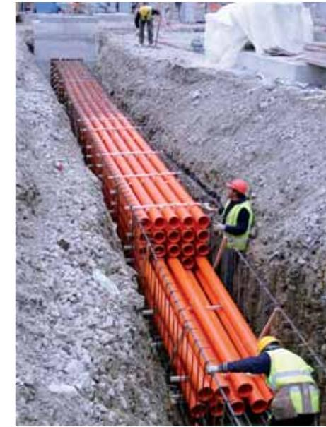
*In questa doppia pagina, fasi di realizzazione dei sistemi di drenaggio delle acque e del complesso sistema di "banchitubo" per il passaggio di cavi elettrici che collegano tutti gli edifici costituenti la centrale.*
