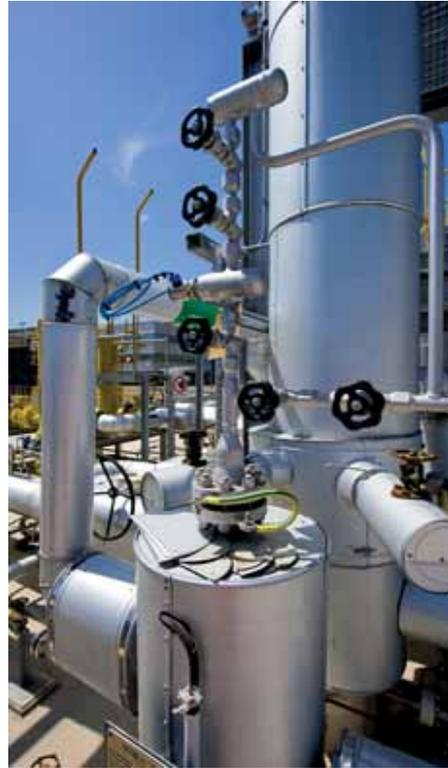
Nella pagina seguente, una veduta complessiva del basamento "Pre-Heater Gas" di Unità 2. Le varie colorazioni riportate sulle condotte sono legate alla natura del fluido collettato. In particolare, il colore giallo identifica il gas naturale, quello verde contraddistingue l'acqua allo stato liquido (impiantistica realizzata da Alstom Power Spa).
