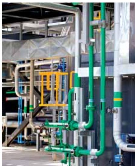
*Nelle quattro foto soprastanti, particolari delle strutture in acciaio (frack) utilizzate per la distribuzione dei cavi elettrici di interconnessione tra il generatore e il locale elettrico e delle condotte aero-fluidiche.*
