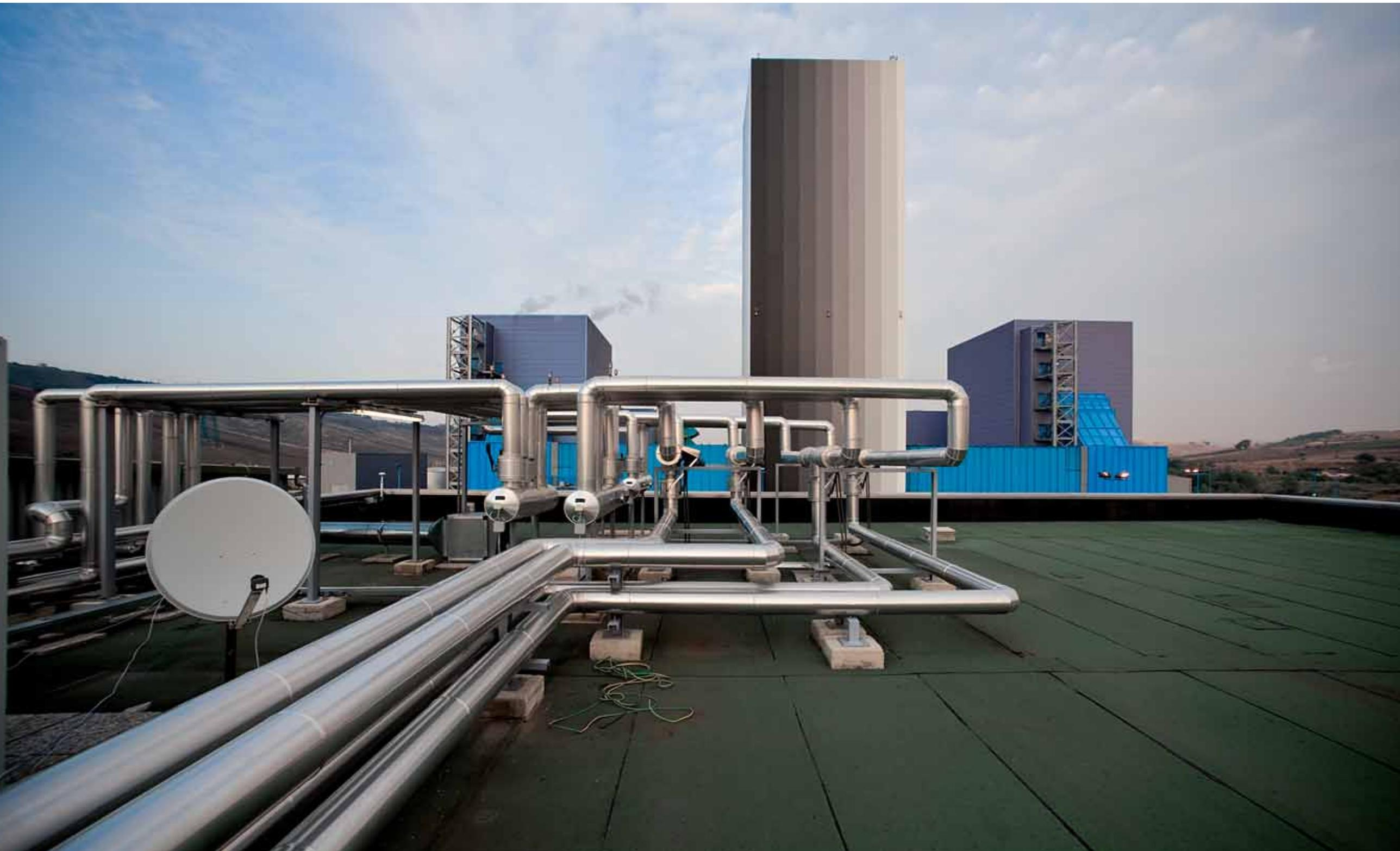
*In questa doppia pagina, veduta della Centrale dal tetto del control building; sullo sfondo il camino collegato dal tubo fumo con le due caldaie dell'impianto (impiantistica realizzata da Alstom Power Spa).*
