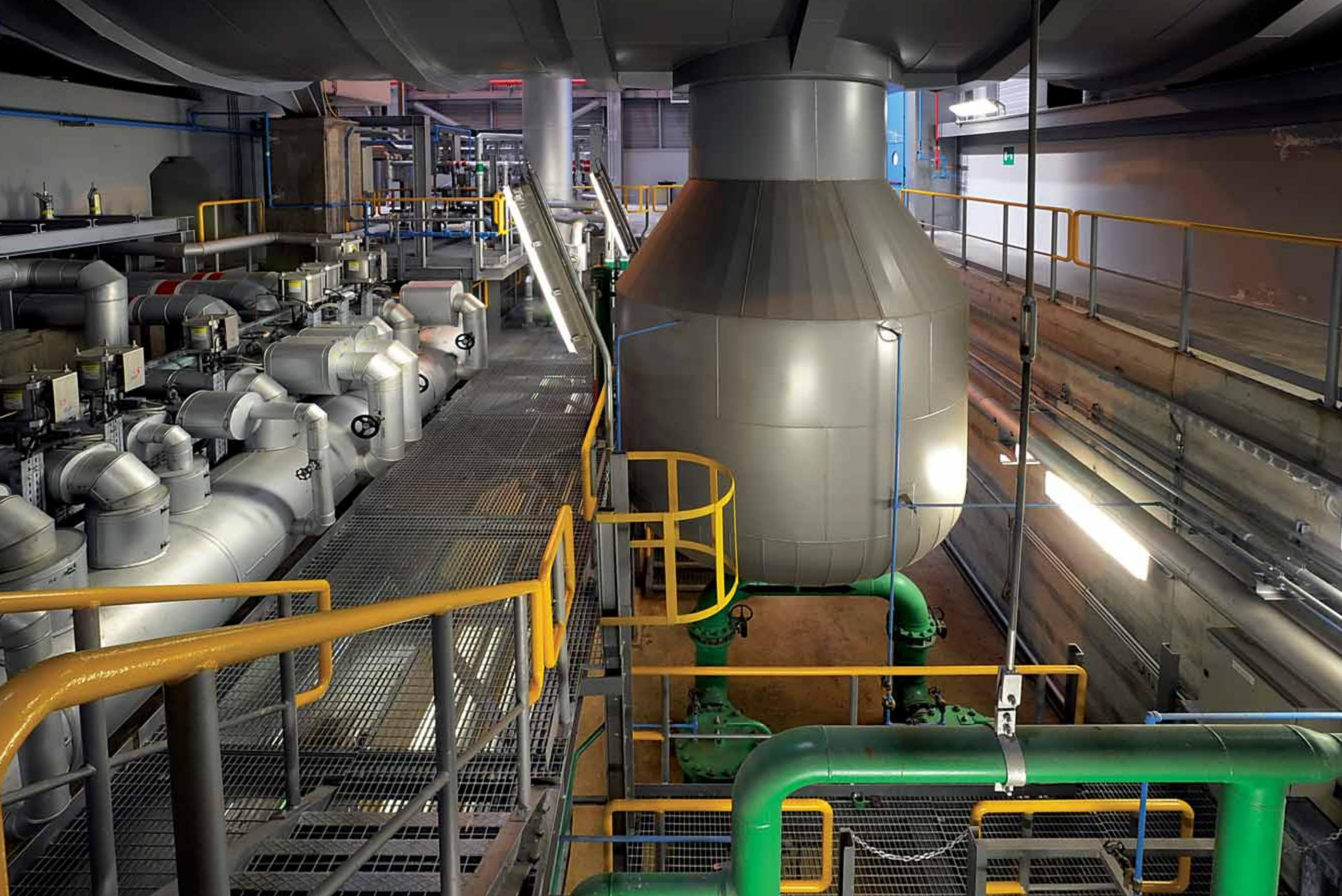
*In questa doppia pagina, una vista d'insieme del pozzo di raccolta del condensato (collocato a valle della turbina a vapore) che a mezzo impianti di pompaggio e di rilancio viene reimmesso nel ciclo*
