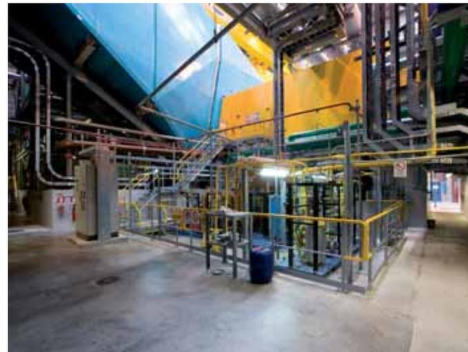
*A fianco, una vista interna della casa macchine, con dettaglio sulle pipeline e sulle linee elettriche di alimentazione delle strumentazioni di controllo dei corpi macchina.*
