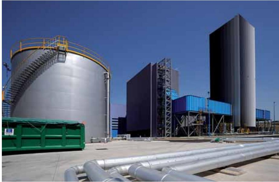
In basso, una panoramica della zona sud-est centrata sul condotto fumi della seconda unità. Sulla destra, il gruppo di preriscaldamento del gas naturale con le relative pipelines. Le emissioni in atmosfera prodotte dalla Centrale vengono costantemente tenute sotto controllo da diverse stazioni di monitoraggio collocate sul territorio, i cui risultati sono a disposizione della popolazione tramite due pannelli informativi costantemente aggiornati.
