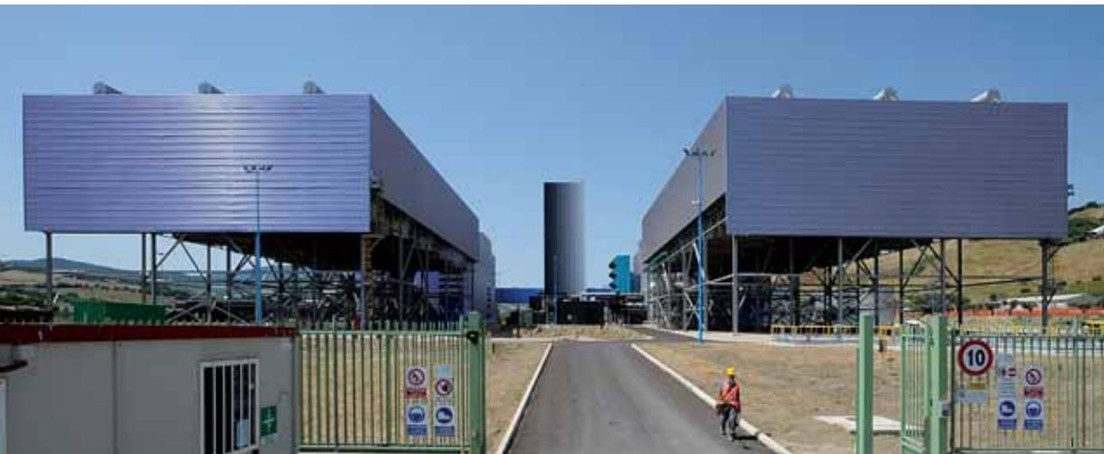
*In alto, una vista dell'impianto dalla sua direttrice nord-sud. L'immagine evidenzia l'articolazione dell'impianto in due unità distinte, collegate al cammino di evacuazione fumi secondo una geometria perfettamente simmetrica rispetto allo stesso.*
