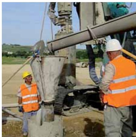
*In questa doppia pagina, una dettagliata sequenza della realizzazione delle palificazioni di fondazione delle piattaforme di sostegno dell'erigendo impianto termoelettrico.*
