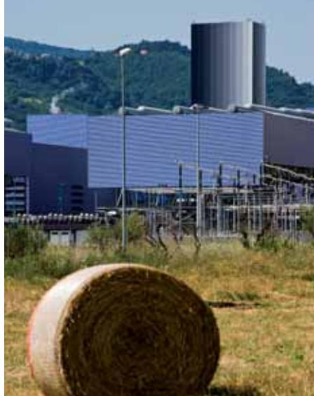
*A sinistra, uno scorcio dell'impianto visto dalla zona nord. In primo piano uno dei due sistemi di raffreddamento ad aria, alle cui spalle si erge il camino di evacuazione avente un'altezza complessiva di circa 65 metri.*
